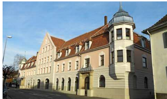
Die 1907 in der Formsprache des Neubarock neu gestaltete Fassade der ehemaligen Mechanischen Weberei Forkel
