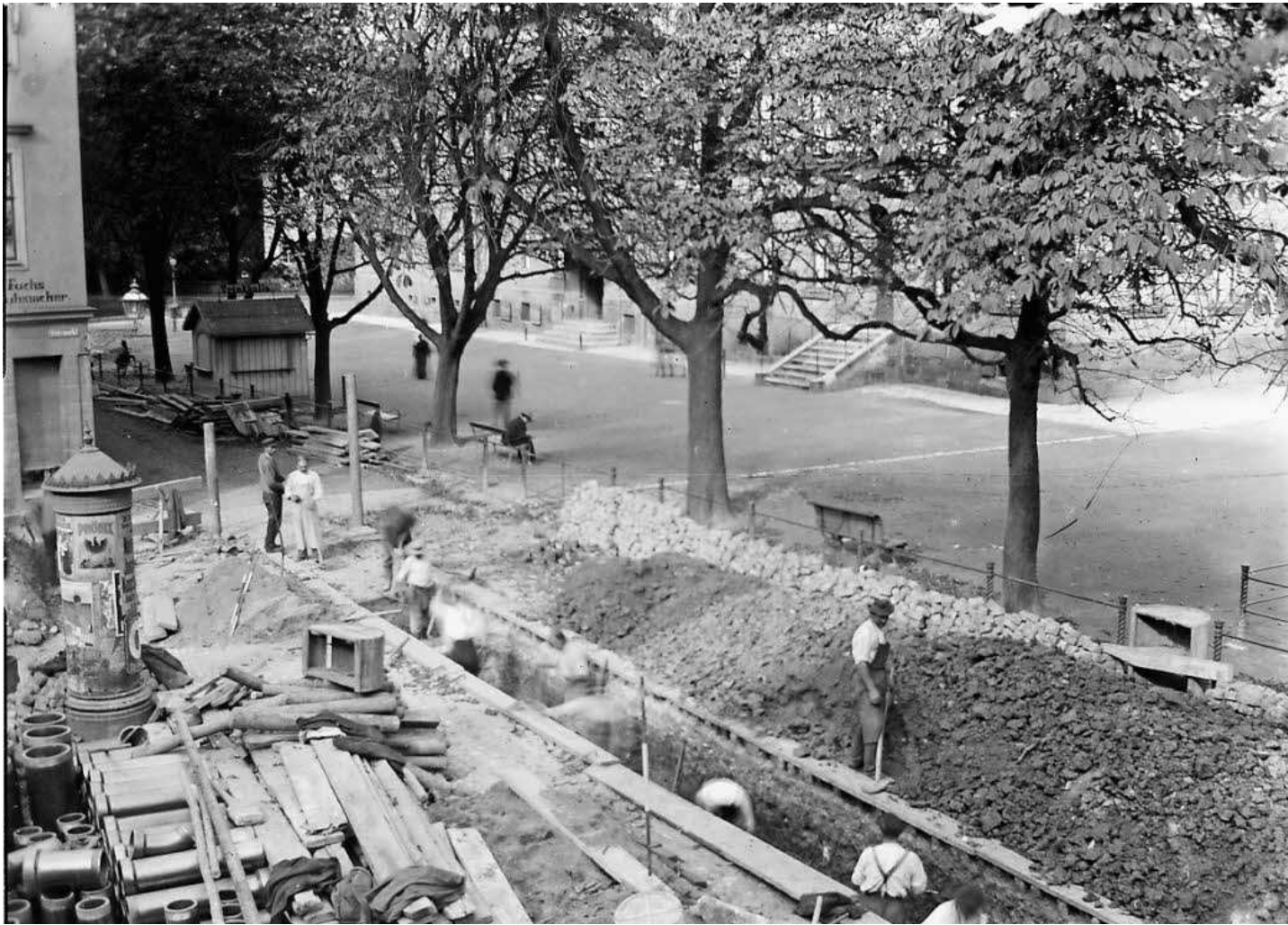
Bau der Schwemmkanalisation am Salzmarkt in Coburg, 1907
