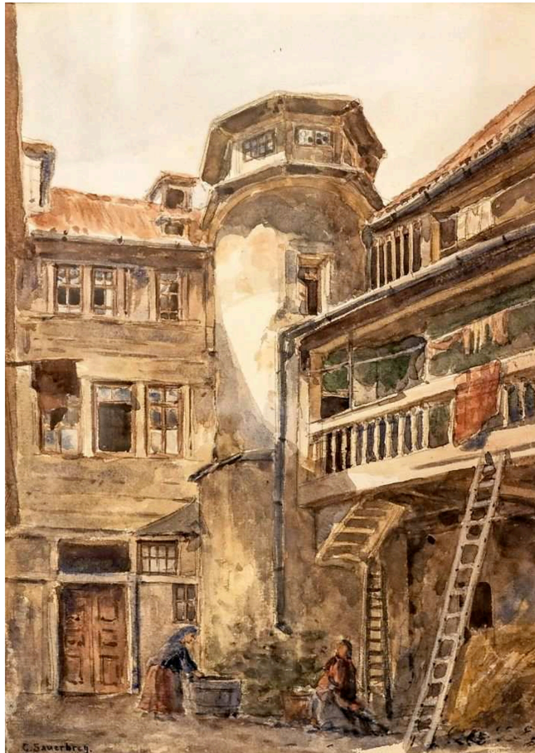
Carl Sauerbrey: Herrngasse 17, Treppenturm im Hinterhof. Dieses Gemälde aus dem Bestand der Städtischen Sammlungen Coburg entstand vor 1947. Es zeigt das Gebäude, in dem sich heute die Stadtbücherei befindet, vor dem Abriss in den 1960er Jahren. Erhalten blieb nur die historische Renaissance-Fassade. Foto: SSC
